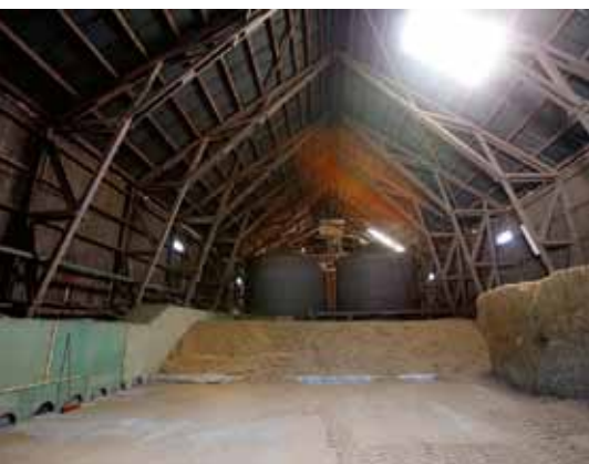
Skörden torkas och lagras på gjutet golv med pansartoppar, 1,80 m eller högre beroende på betingelserna vid skörd.
